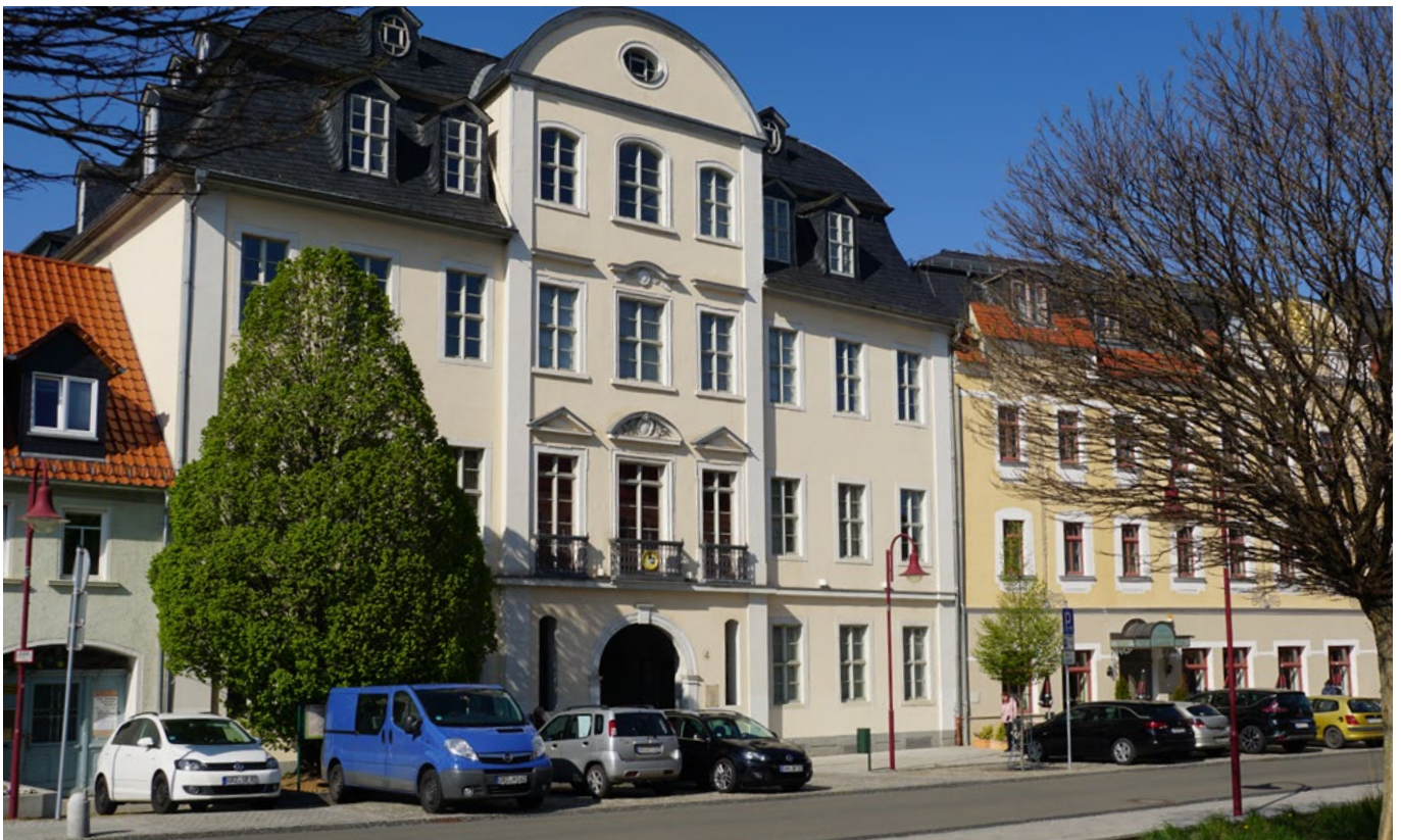
Abb. 14: Wehranlage Weiße Elster Bad Köstritz
