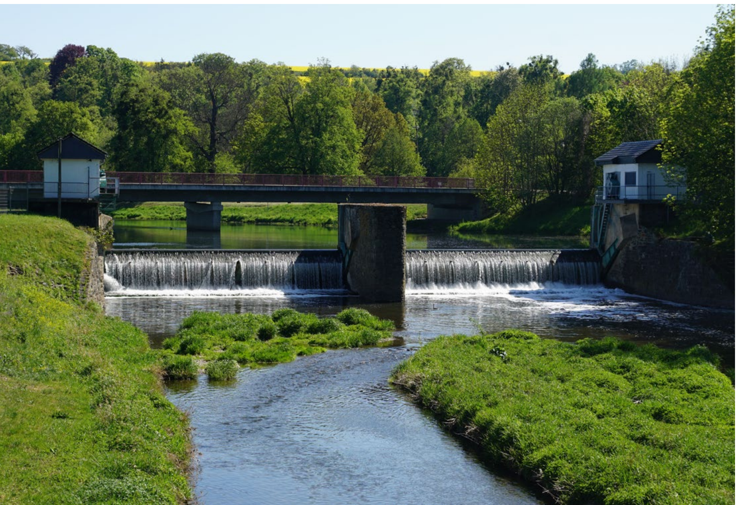
Abb. 13: Wehranlage Weiße Elster Bad Köstritz
