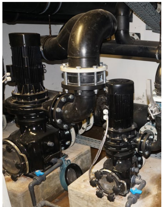
Abb. 19: Erneuerung mit energieeffizienten Pumpen im Freizeit- und Erholungsbad
