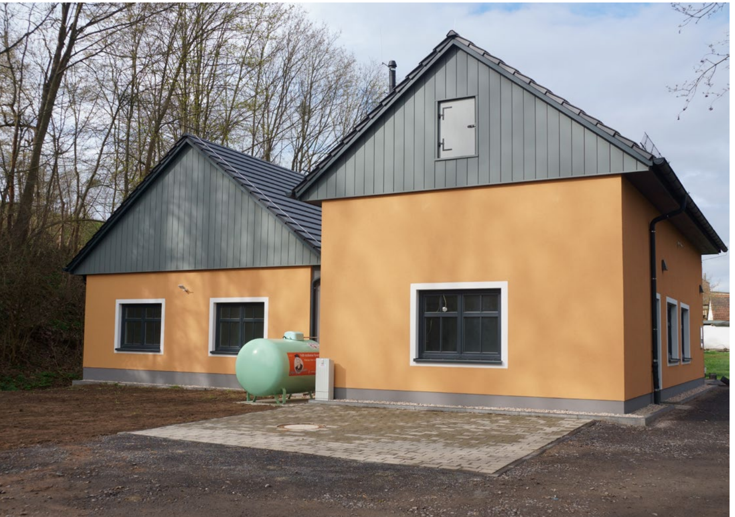
Abb. 11: Dorfgemeinschaftshaus im Ortsteil Reichardttdorf mit Biokläranlage
