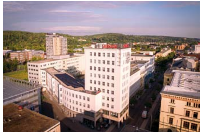
Handelshof-Gebäudekomplex der Sparkasse Gera-Greiz in der Geraer Schloßstraße.
