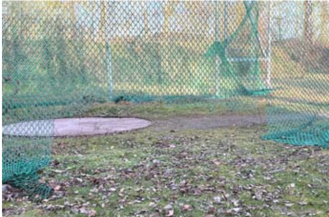
Durch Vandalismus und ohne eine Spur schlechten Gewissens wurde das Sicherheitsnetz der Wurfanlage zerstört. (Foto: LAV Elstertal Bad Köstritz e. V.)
